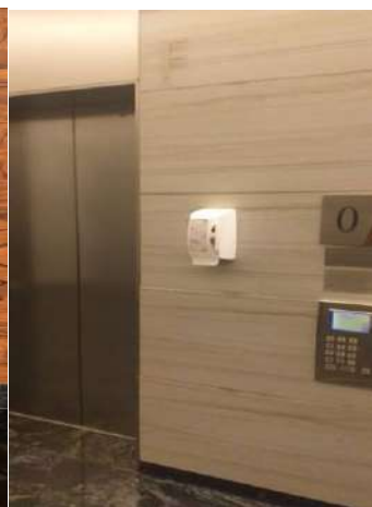
Foto 22 – Dispenser Hall dos elevadores
