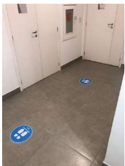
Foto 14 – Portaria de Serviço
