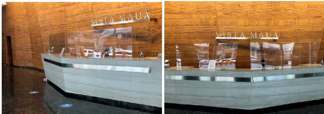
Foto 24 – Barreira de Acrílico Balcão Lobby
