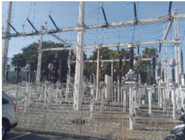
Figura 3: Subestação de entrada de energia elétrica em 88kV após reforma
