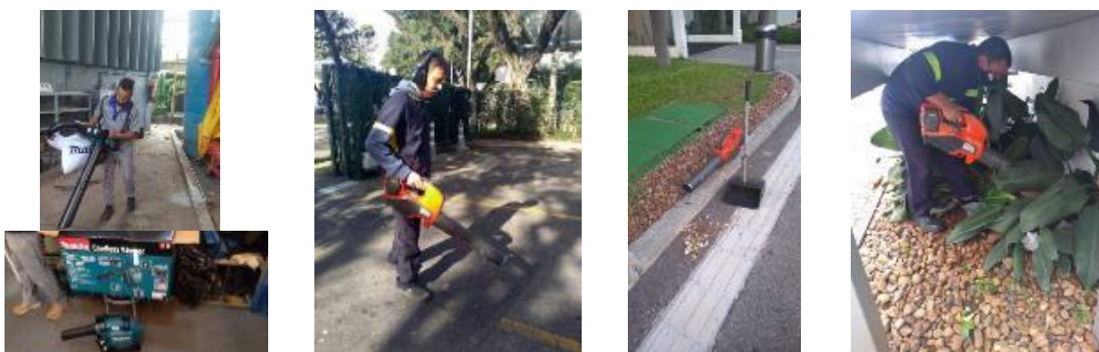
Figuras 19,20 e 21: Sopradores e aspiradores elétricos em operação
