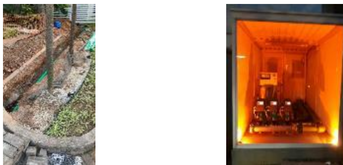
Figuras 28 e 29: Tubulações substituídas e motobombas autocontroladas por pressão da rede
